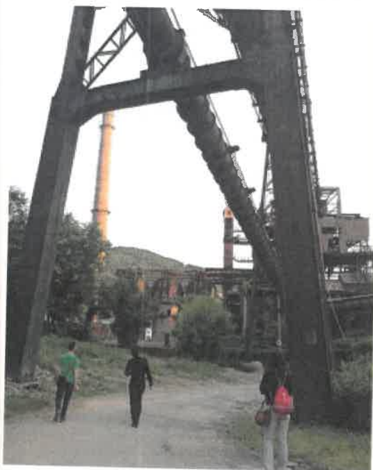
Foto: Instalații abandonate parte fostul furnalul de fontă al Combinatului Siderurgic, deasupra Str. Feroviarului, calea de acces pre ZUM Dealu Crucii.
